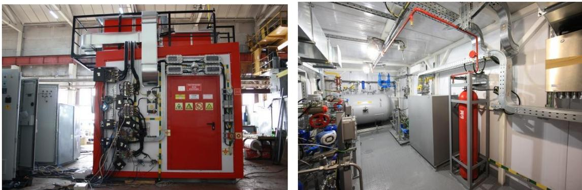
Узел дозирования одоранта представляет собой комплекс оборудования и систему трубопроводов для дозирования одоранта в две линии - ПБТ и БТ, и состоит из: рабочих и резервных агрегатов, линий нагнетания в ПБТ и в БТ, линий всасывания, линии очистки и нейтрализации, линии слива в дренаж, линии воздуха КИП, и приборов КИП для контроля рабочих параметров установки.
