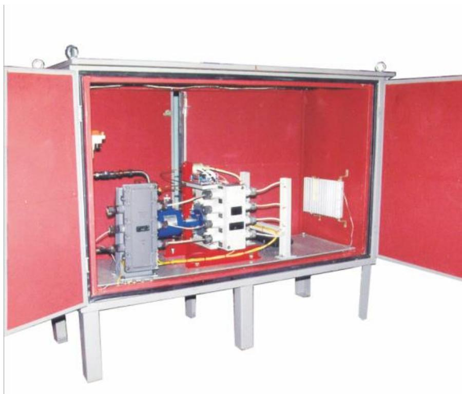
Установка насосная дозирующая (далее по тексту установка) предназначена для ввода одоранта в поток газа пропорционально его расходу.
